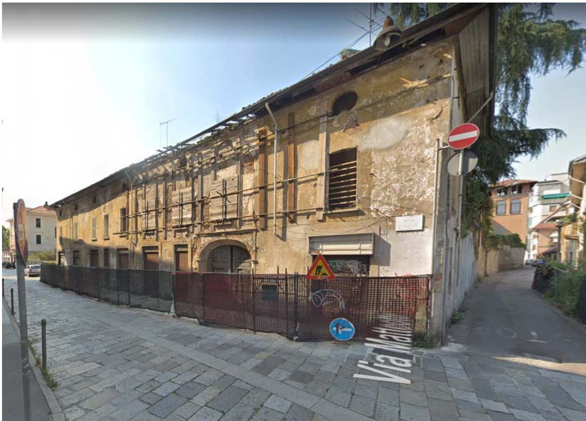
Foto 2 – Fronte principale su via Matteotti
