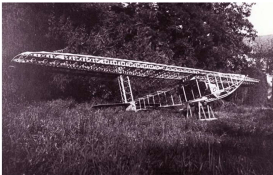
La struttura dell'aliante G.P.1 prima dell'applicazione del rivestimento
